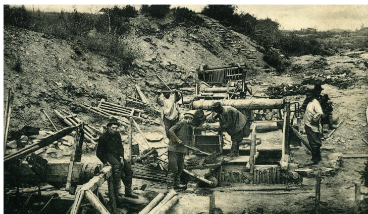
Добыча песков из шурфа
