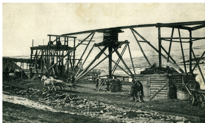
Устройство для конного подъема породы из шахты
