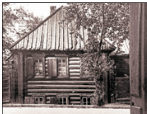
«Горбатый дом» в Иркутске по ул. Пятой Армии. Сломан в 1961 г.
