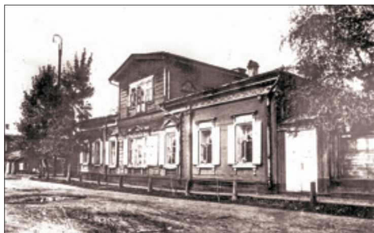
Дом по Харлампиевской улице в Иркутске. Фото кон. XIX в.
